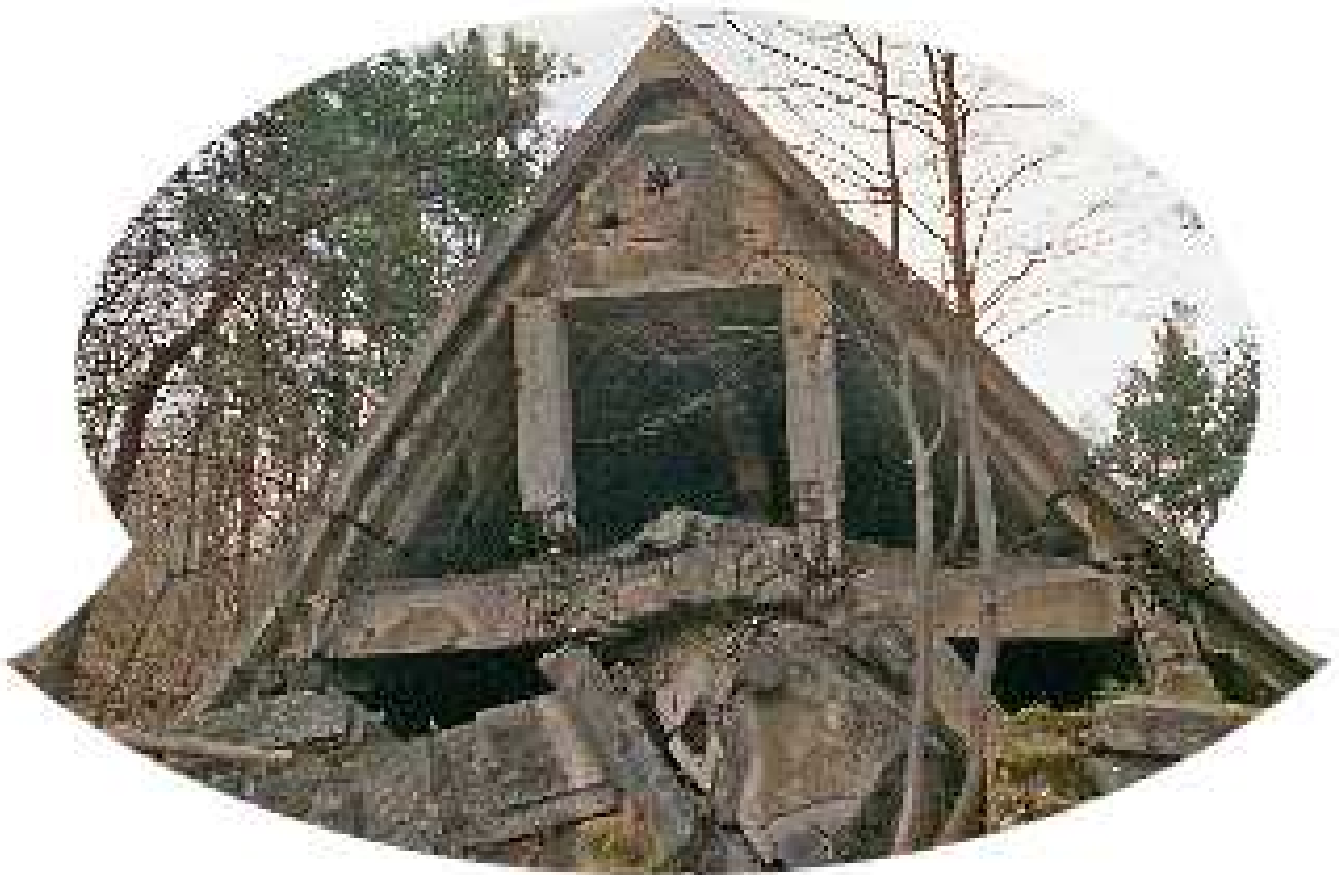
Fausses maisons au sous-sol desquelles se trouvent les PC de commandement
