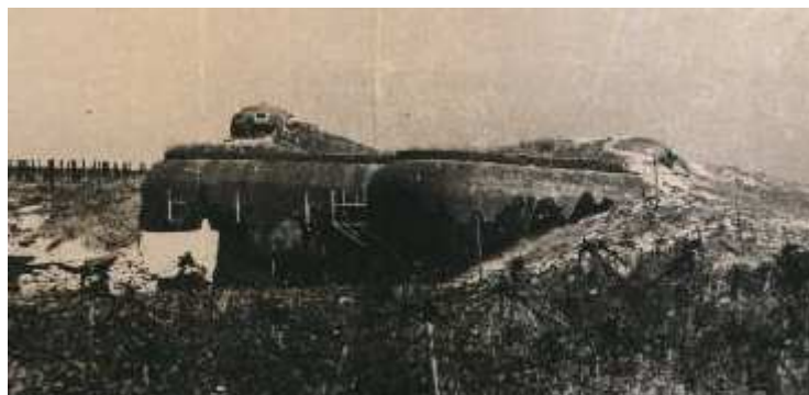
Exemple de camouflage du béton et cloches du Secteur
