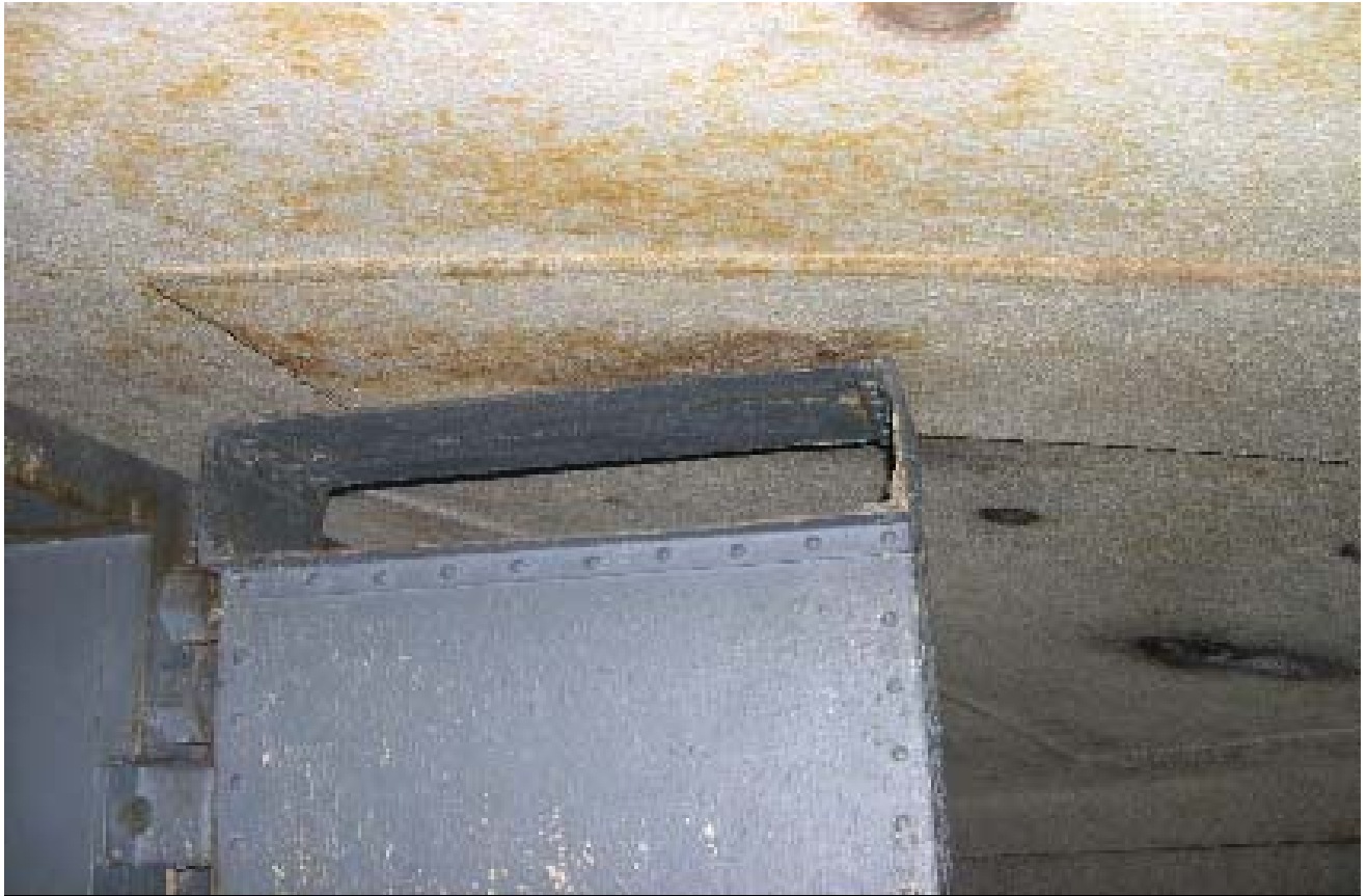
Système d'aspiration des gaz de la chambre de tir
