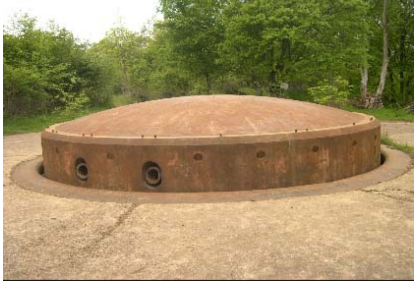
Tourelle en position de tir
