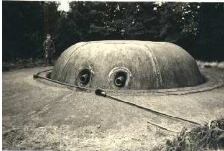
Tourelle en fonte système MOUGIN en 1940.
