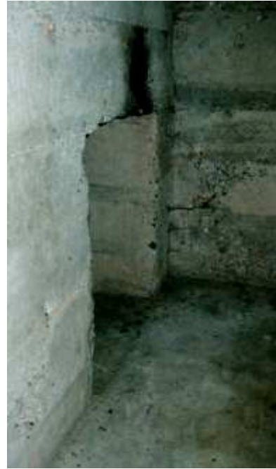
Vue du fourneau, c'est dans cette niche que devait être déposé les explosifs
